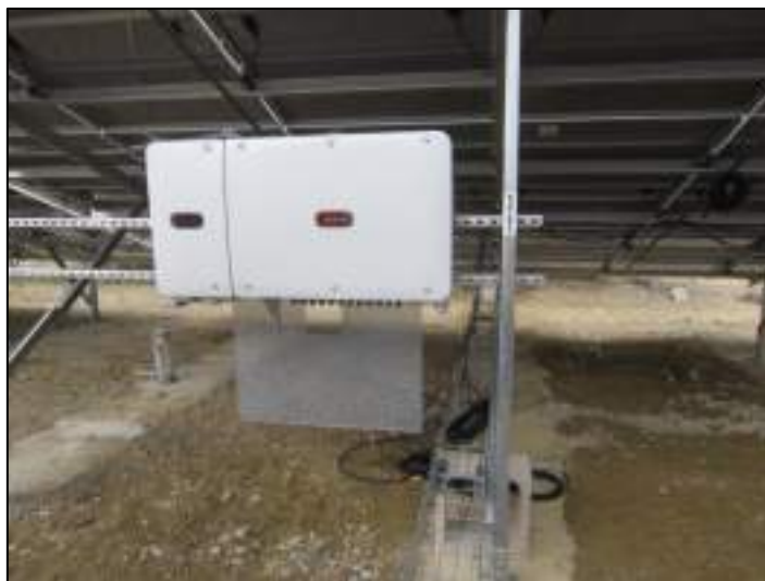
Illustration 53 : Exemple d'onduleur décentralisé
