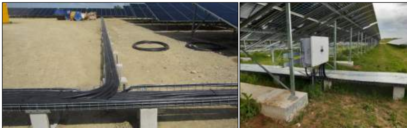
Illustration 51 : Photographies de l'installation du raccordement électrique
