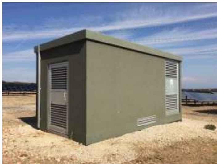
Illustration 52 : Exemple de poste de conversion « indoor »
