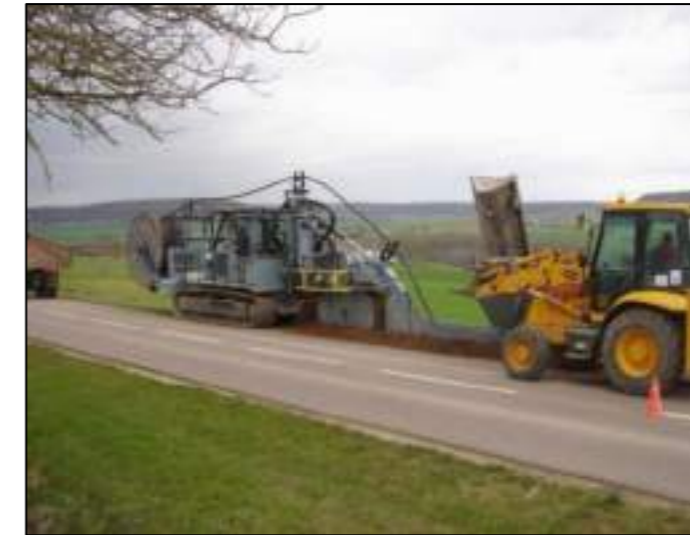
Réalisation d'une tranchée
