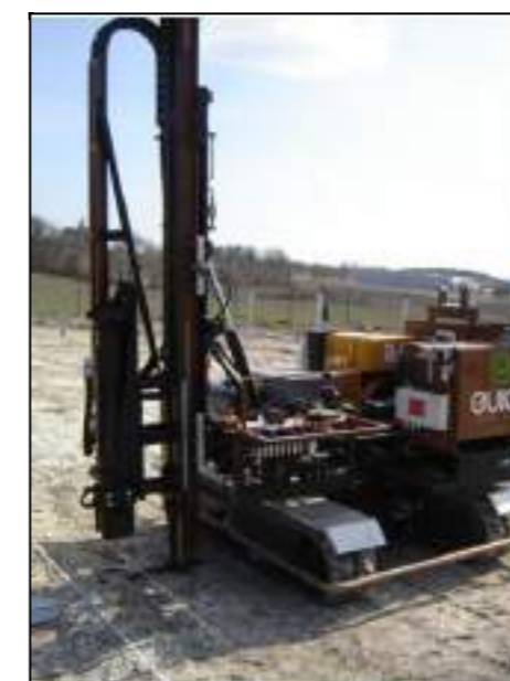
Engin de battage de pieux
