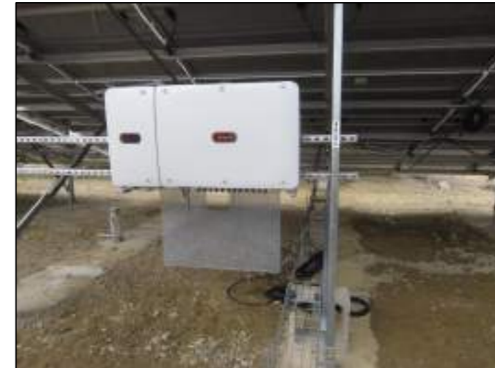
Exemple d'onduleur décentralisé
