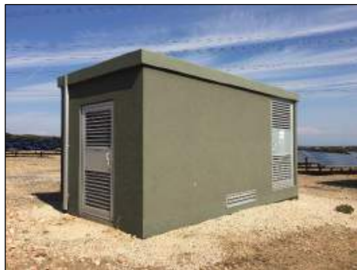
Exemple de poste de conversion « indoor »
